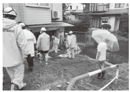
諏訪湖周辺の内水氾濫と消防団の活躍
